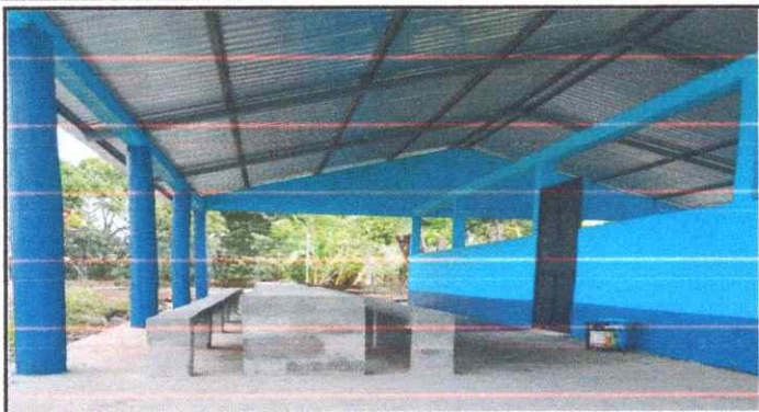
Foto1: Muestra de la culminación de la construcción.
